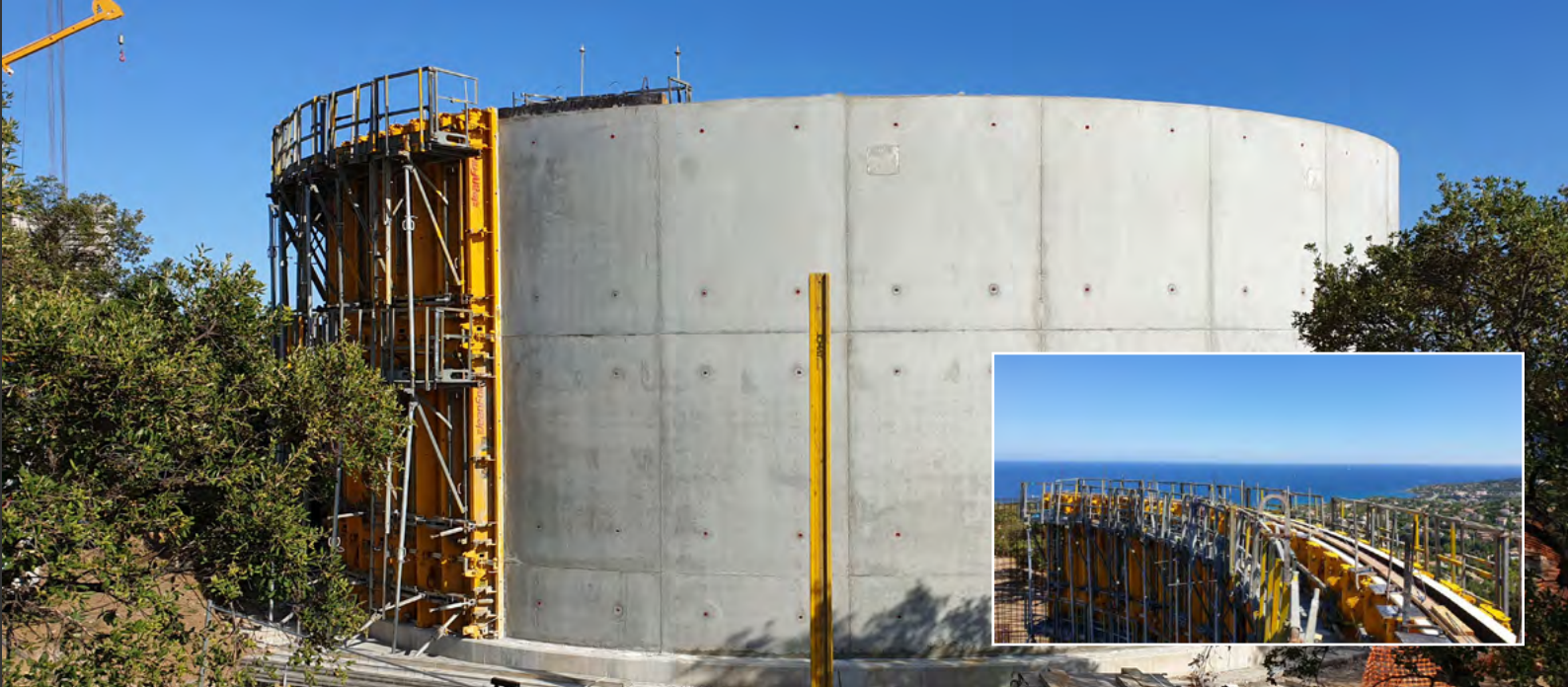
Travaux de construction du réservoir d'eau potable (1600 m 3 ) de Saint-Aygulf (83) en 2019 - 1 101 284 €
