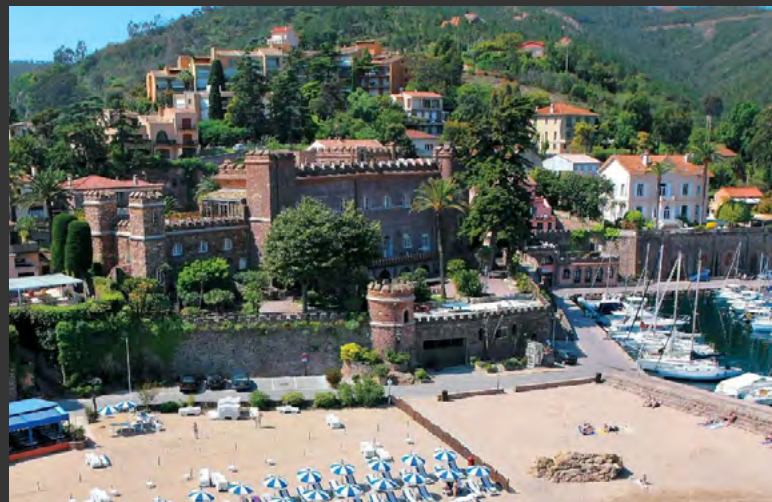
Rénovation du Château de Théoule sur Mer (06) en ensemble Hôtelier et Touristique en 2022 - 2 600 000 €
