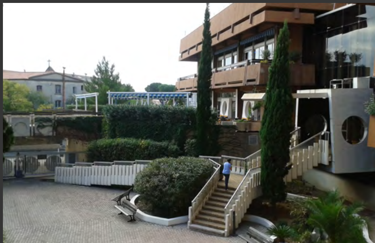
Rénovation de l'Escale Louvois (Démolition, reprise en sous-œuvre, maçonnerie menuiserie ext.) à Toulon (83) en 2022 - 2 930 000 €
