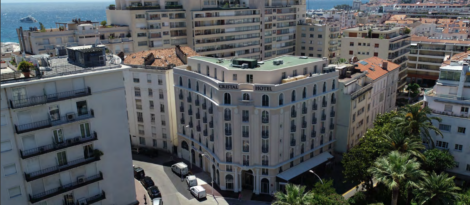
Surélévation et agrandissement de l'Hôtel Cristal, en plein centre de Cannes (06) en 2017 - 1 300 000€
