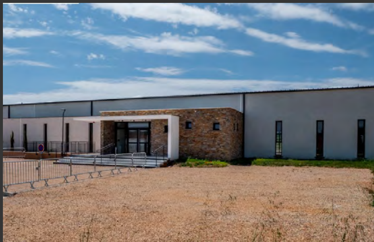
Construction d'une salle communale sur le complexe sportif Paul Emeric à Garéoult (83) en 2020 - 599 862 €
