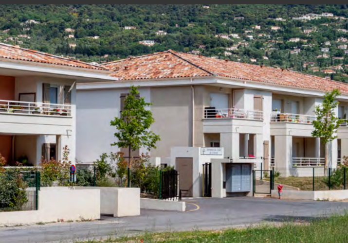
Construction de 25 logements et 9 villas individuelles au Tignet (06) en 2019 - 1 400 000 €
