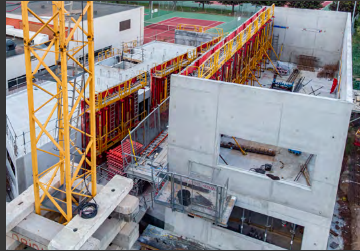
Gros œuvre et structure bois pour la Construction d'une Maison de Santé à Solliès-Pont(83) en 2022 - 625 000 €
