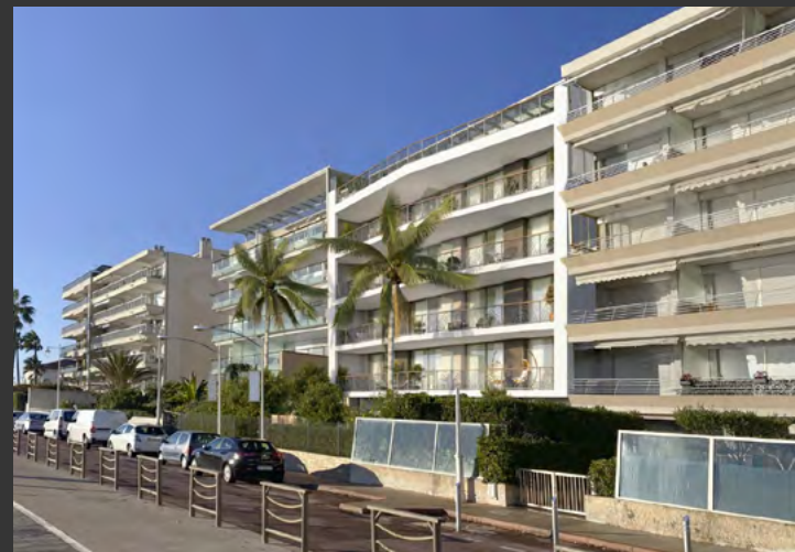
Construction de 8 logements et 3 bureaux Hélios à Cannes (06) en 2023 - 1 270 000 €
