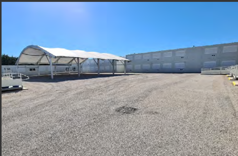
Fondations pour la création du collège provisoire du collège Henri Nans à Aups (83) en 2020 - 548 701 €
