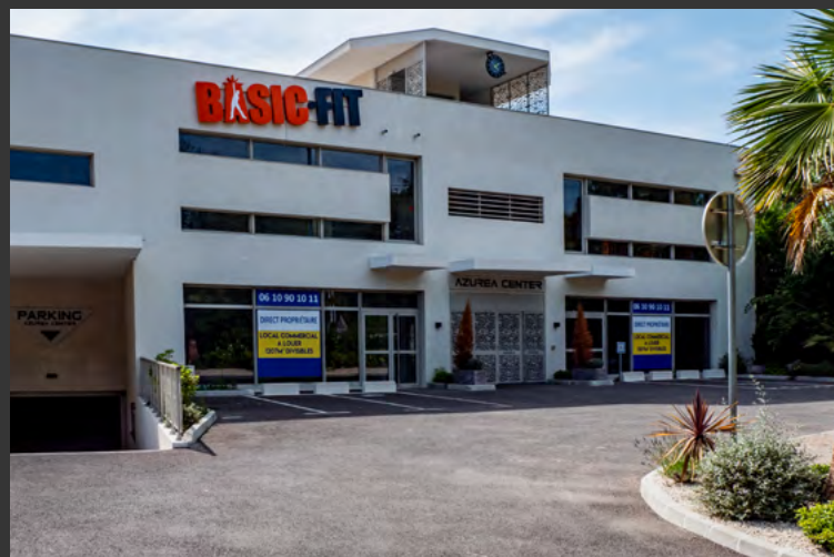
Création d'un bâtiment de commerces et bureaux Azurea Center à La Colle sur Loup (06) en 2019 - 1 350 000 €
