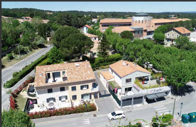
Gros œuvre pour construction de 9 logements à Gréasque (13) en 2015 - 430 000 €
