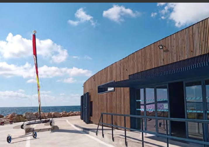
Construction de la base nautique de Sanary-sur-Mer (83) en 2020 - 400 000 €
