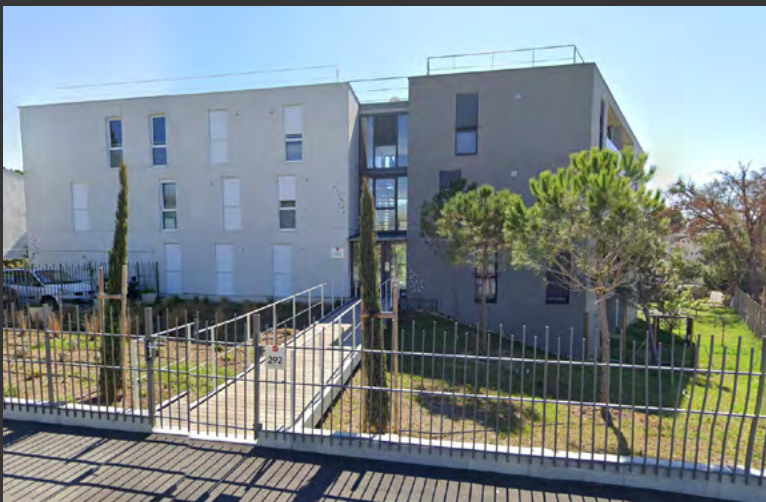
Construction de 14 logements à St-Raphaël (83), Résidence Carthage en 2019 - 899 562 €
