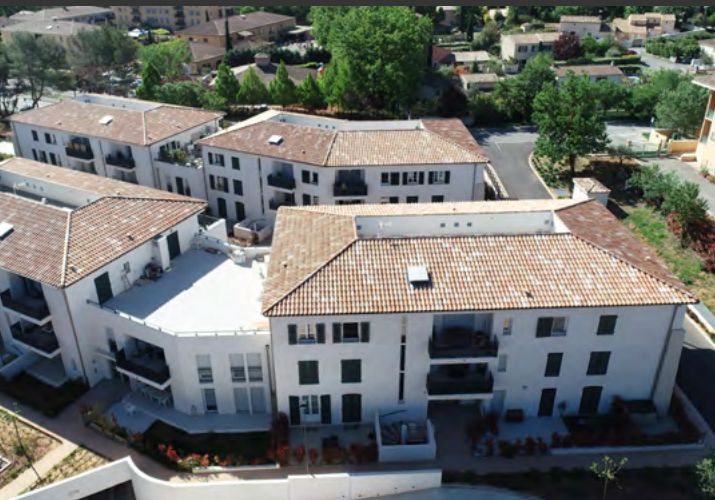
Gros œuvre pour construction de 92 logements sur 8 bâtiments à Chateauneuf-Le-Rouge (13) en 2015 - 4 160 000 €
