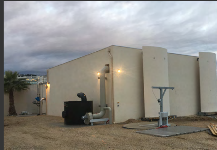
Création d'une unité d'épaississement des boues secondaires par table d'égouttage pour la STEP Haliotis de Nice (06) en 2022 - 420 000 €
