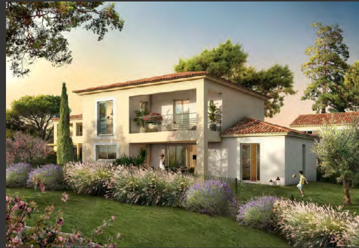
Construction d'un ensemble de 15 Villas Les Bastides de Julie à St Maxime (83) en 2022 - 930 000 €
