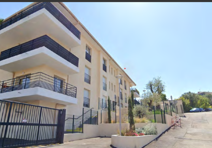
Construction de 14 logements, Rosalie Park à Grasse (06) en 2018 - 500 000 €
