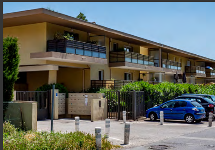
Terrassement, GO, VRD, façades, espaces Vert pour construction de 23 logements et 3 maisons individuelles à La Colle sur Loup en 2018
