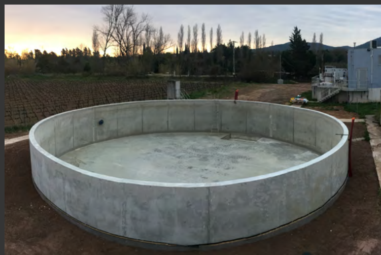
Travaux de réhabilitation du bassin d'orage (680 m 3 ) de la station d'épuration des Planets à Roquebrune-sur-Argens (83) en 2022 - 425 000 €
