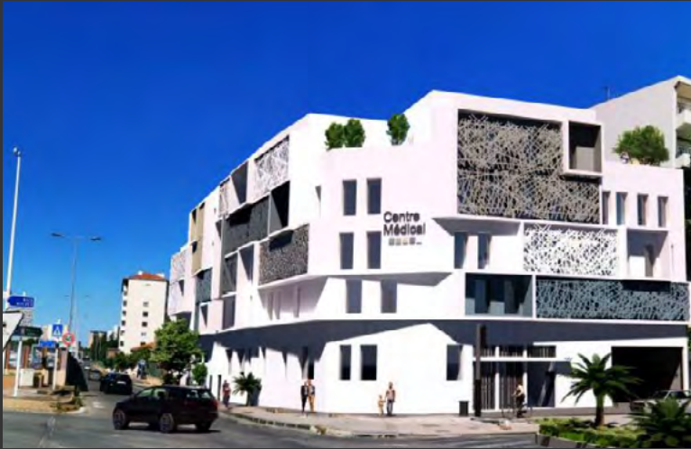
Construction d'un Pôle Santé à Toulon (83) en 2023 - 2 143 000 €
