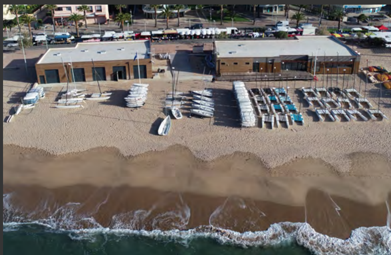
Fondations spéciales et gros œuvre d'un centre nautique) à Fréjus (83) en 2017 - 183 000 €
