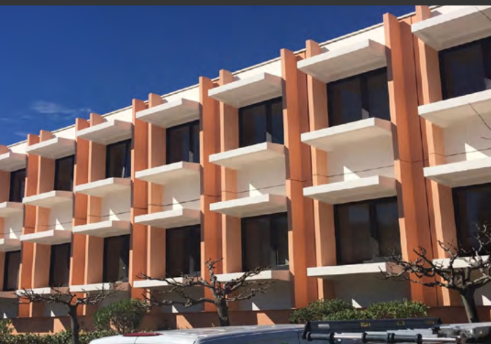
Transformation de locaux existants en centre médical à Valbonne (06) en 2016 - 410 000 €
