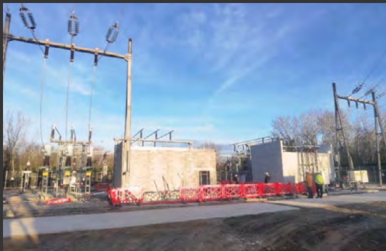
Construction du poste source Enedis à Font d'Irac (84) en 2022-23 - 469 000 €
