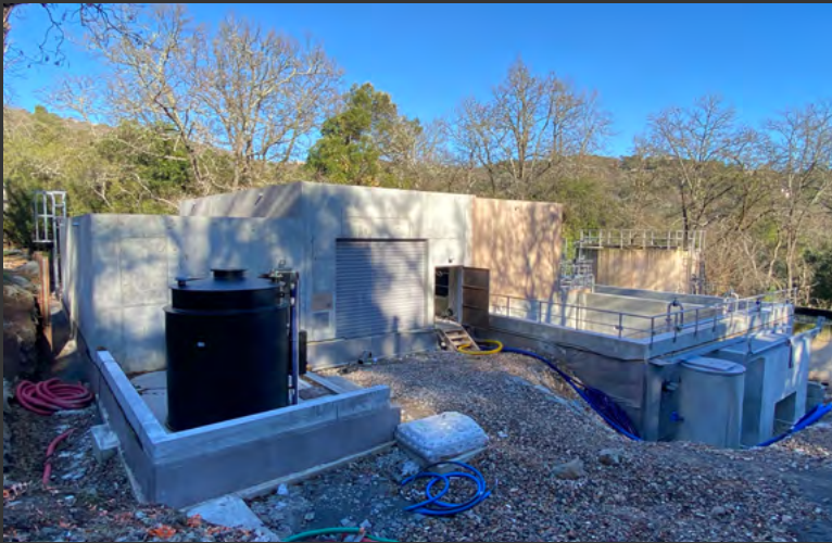
Marché de Conception Réalisation pour la reconstruction de la STEP « Pré vert » aux Adrets de l'Esterel (83) en 2020 - 2 170 000 €
