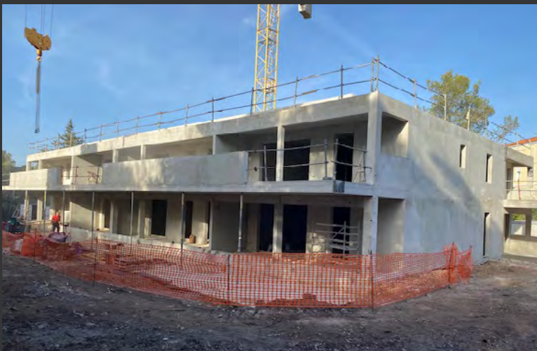
Construction d'un bâtiment comprenant 11 logements Villa Giulia à St-Raphaël (83) en 2022 - 665 000 €
