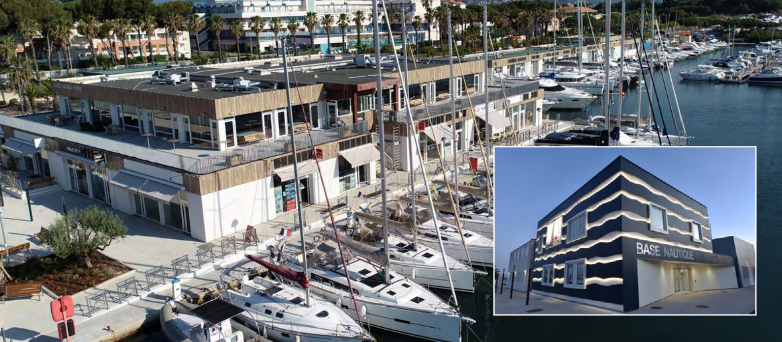
Travaux de réhabilitation du centre commercial du nautisme, de la base nautique du port et de ses abords à Hyères (83) en 2019 - 3 875 000 €
