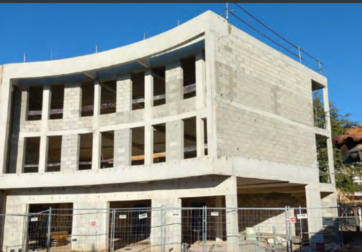
Gros œuvre, carrelages, VRD pour restructuration et extension de l'EHPAD « Pin et Soleil » à Pignans (83) en 2023 - 1 428 550 €
