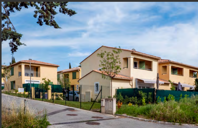
Construction de 10 logements individuelles, Les Coteaux d'Azur à La Colle sur Loup (06) en 2018 - 600 000 €
