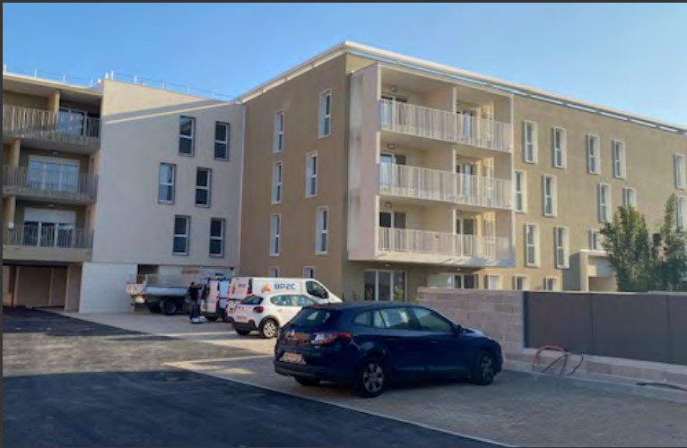
Construction d'une résidence de 28 logements Villa Aurélienne à St-Raphaël (83) en 2022 - 1 055 000 €
