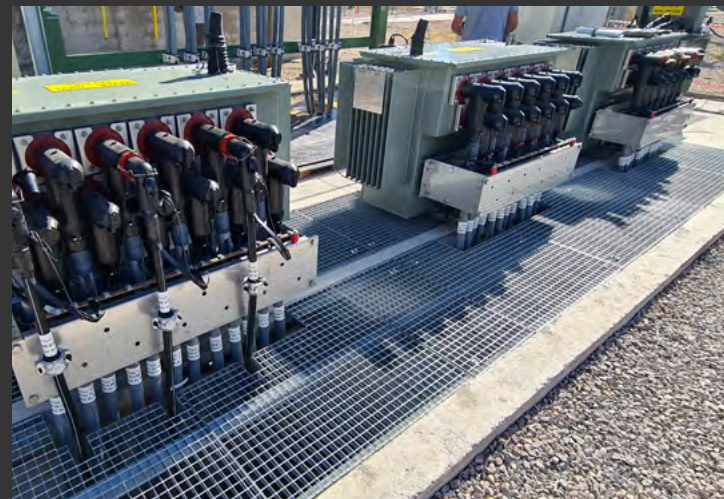
Construction d'un poste source Enedis à Marseille les Caillols (13) en 2022-2023 690 000 €
