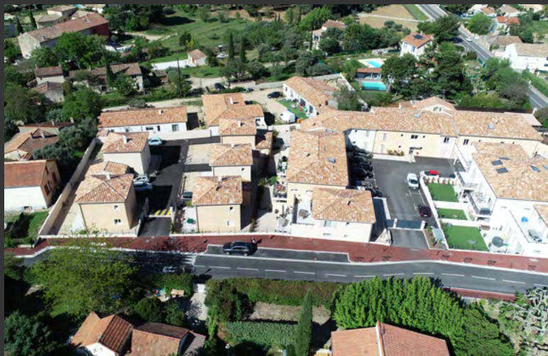
Construction (Macro-lot) de 29 logements et 5 maisons individuelles à Géménos (13) en 2016 - 2 005 110 €
