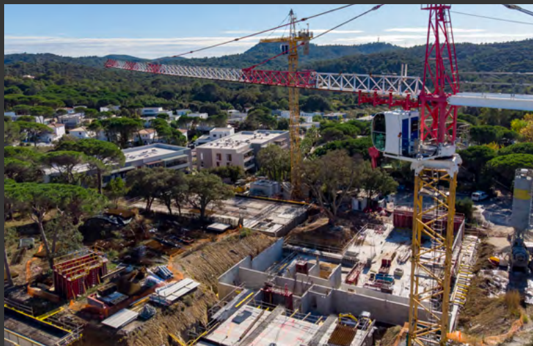
Construction d'une résidence d'hébergement touristique Douce Quiétude à St Raphaël (83) en 2022 - 2 949 500 €
