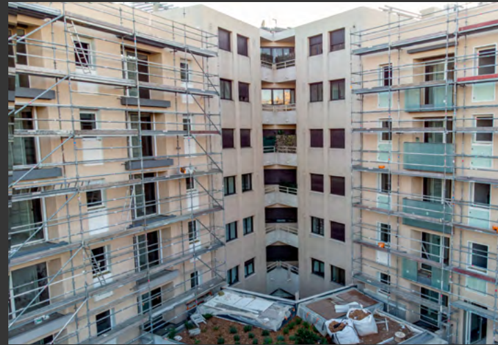
Gros-œuvre, fondations profondes, terrassement, parois moulées pour construction d'une résidence seniors SAH à Antibes (06) en 2021 - 2 940 861 €
