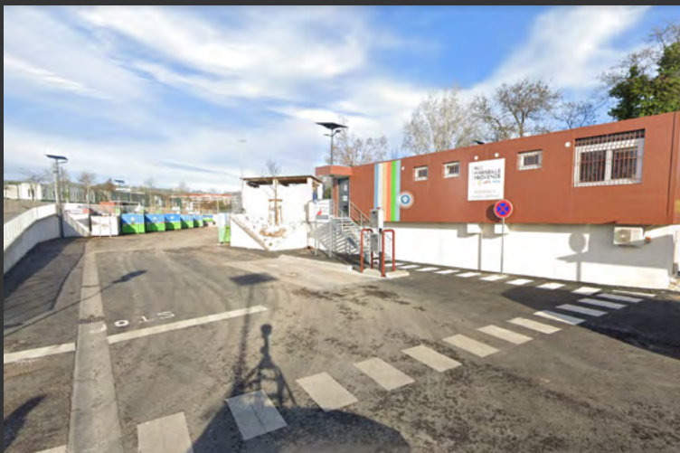
Démolition, Terrassement, Génie Civil, VRD pour réaménagement et extension de la déchetterie de Château Gombert (13) en 2020 - 1 093 287 €
