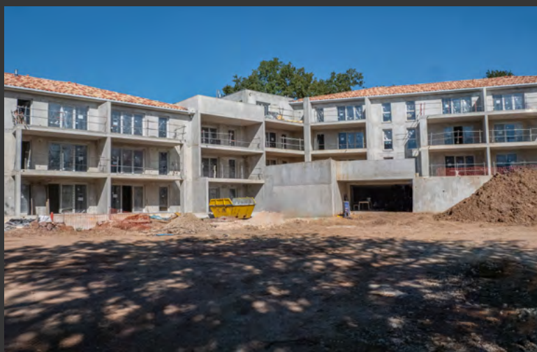
Construction de 38 logements collectifs Les Jardins d'Elia à Pierrefeu du Var (83) en 2021 - 1 650 000 €
