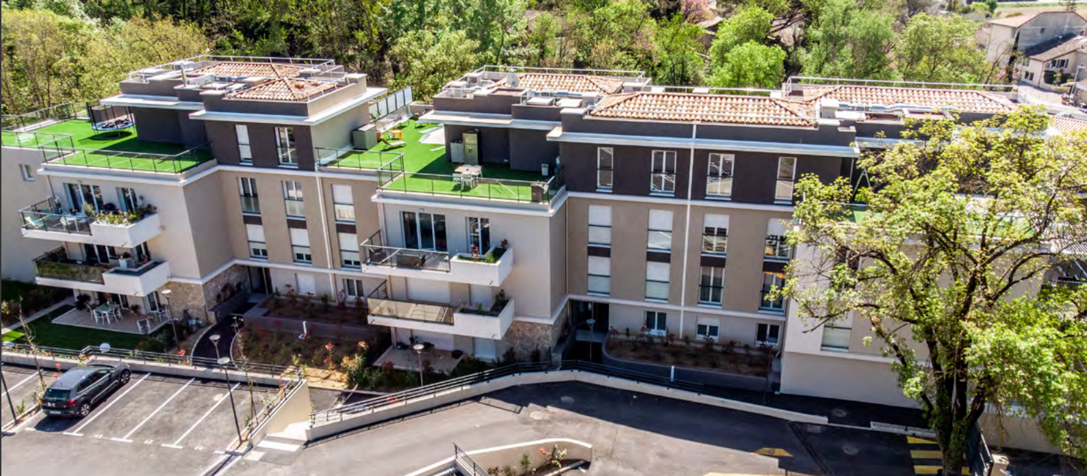
Construction d'un immeuble de 59 logements, Aura Bella à Auribeau-sur-Siagne (06) en 2019 - 2 200 000 €
