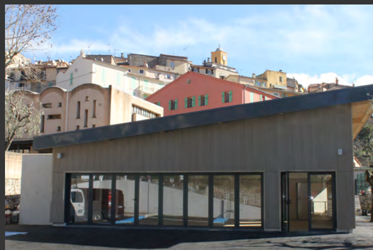
Construction d'une salle polyvalente à Gattières (06) en 2018 - 191 268 €
